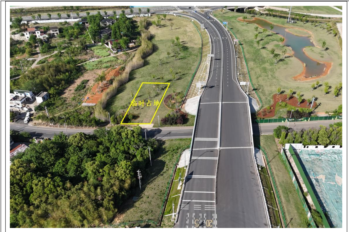
图 4.1 (A) 临时占地恢复情况 (航拍)
