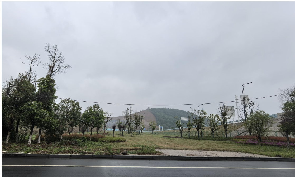
图 4.1 (B) 临时占地恢复情况 (踏勘)
